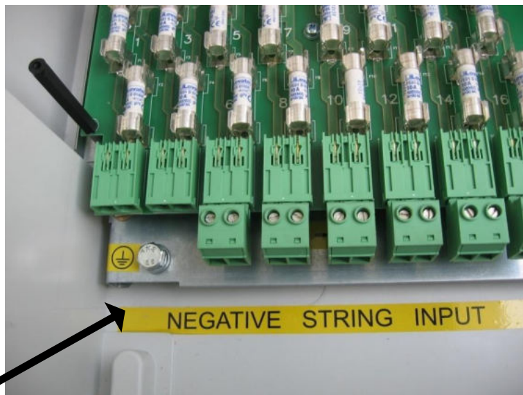
Conexión del cable de tierra
